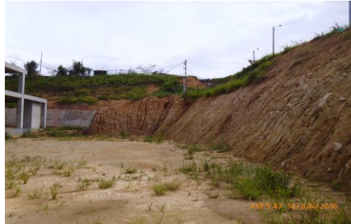
Taludes sin protección costado nororiental
