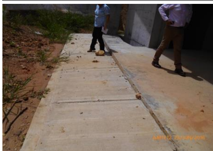
Andén caído- esquina costado nor oriental de la edificación -gran salón
