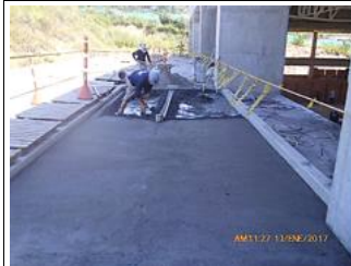
Proceso del vaciado de mortero de nivelación piso 2 , viga canal el costado noroccidental.
