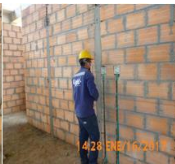
Instalación de ductos plásticos para salida de tomacorrientes e interruptores . Instalación de ductos EMT para red de iluminación en Sótano 2.
