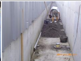
Proceso del vaciado de mortero de nivelación piso 2 , viga canal el costado noroccidental.
