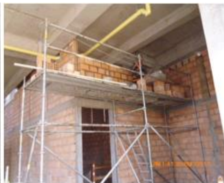
Construcción de mampostería H-15 (ampostería después de vigueta hasta la viga)
