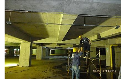
Instalación de ductos plásticos para salida de tomacorrientes e interruptores costado norte gran salón. Instalación de ductos EMT para red de iluminación en Sótano 2.
