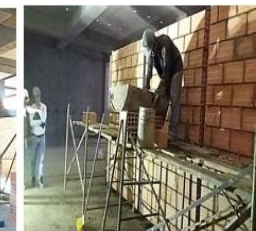
Encofrado y Fundida de viguetas, y vigas dintel confinamiento muro h15 piso 1 Ejes SA1-2, SAB1-2, SB1-2, SC1-2, SD1-2, SGH1-4, Mampostería h15 en Piso 2 Costado Noroccidental, Piso 1 costado Norte, oriental y sur, Sótano 1 área cuarto de seguridad & control; columnetas de confinamiento piso 1 gran salón costado norte, oriental y sur .
