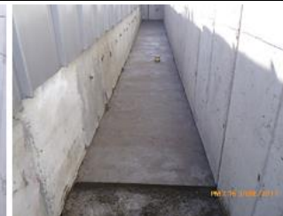
Proceso del vaciado de mortero de nivelación piso 2 , viga canal el costado noroccidental.
