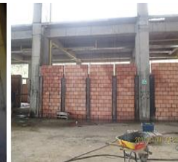
Encofrado y Fundida de viguetas, y vigas dintel confinamiento muro h15 piso 1 Ejes SA1-2, SAB1-2, SB1-2, SC1-2, SD1-2, SGH1-4, Mampostería h15 en Piso 2 Costado Noroccidental, Piso 1 costado Norte, oriental y sur, Sótano 1 área cuarto de seguridad & control; columnetas de confinamiento piso 1 gran salón costado norte, oriental y sur .
