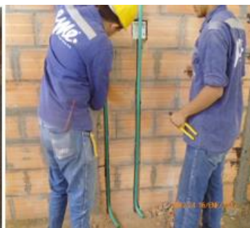
Instalación de ductos plásticos para salida de tomacorrientes e interruptores . Instalación de ductos EMT para red de iluminación en Sótano 2.
