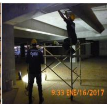
Instalación de ductos plásticos para salida de tomacorrientes e interruptores . Instalación de ductos EMT para red de iluminación en Sótano 2.
