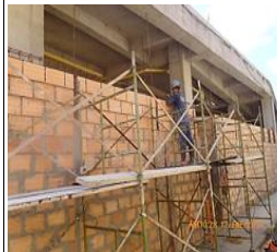
Encofrado y Fundida de viguetas, y vigas dintel confinamiento muro h15 piso 1 Ejes SA1-2, SAB1-2, SB1-2, SC1-2, SD1-2, SGH1-4, Mampostería h15 en Piso 2 Costado Noroccidental, Piso 1 costado Norte, oriental y sur, Sótano 1 área cuarto de seguridad & control; columnetas de confinamiento piso 1 gran salón costado norte, oriental y sur .
