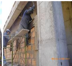
Encofrado y Fundida de viguetas, y vigas dintel confinamiento muro h15 piso 1 Ejes SA1-2, SAB1-2, SB1-2, SC1-2, SD1-2, SGH1-4, Mampostería h15 en Piso 2 Costado Noroccidental, Piso 1 costado Norte, oriental y sur, Sótano 1 área cuarto de seguridad & control; columnetas de confinamiento piso 1 gran salón costado norte, oriental y sur .
