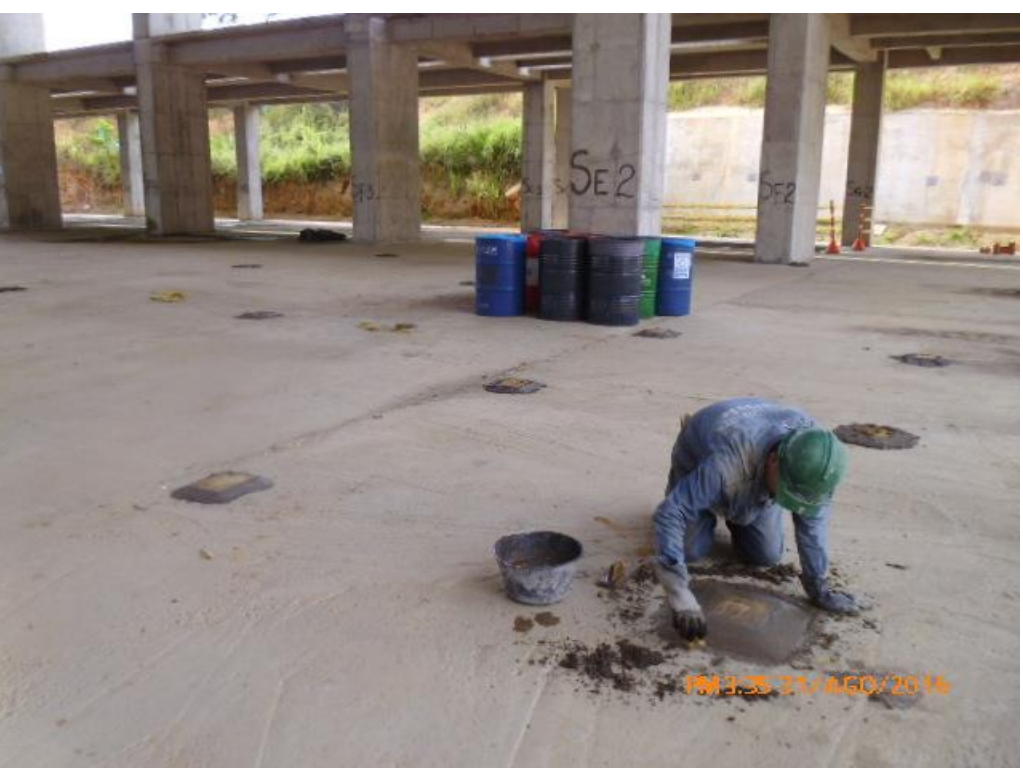
taponamiento temporal de vanos (A.A) por prevención de accidentalidad..
