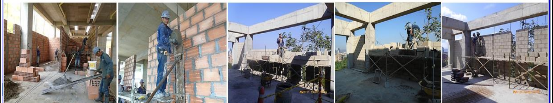
ACTIVIDADES DE MAMPOSTERIA EN H-15 , Y MAMPOSETRIA EN LADRILLO ESTRUCTURAL COSTADO NORTE DEL GRAN SALÓN
