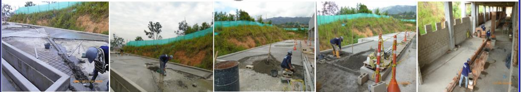
NIVELACIÓN Y ALISTADO DE PISO EN MORTERO PISO 2 EJES: SF4-SF5-SF6-SF7
