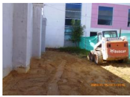
Conformación de rellenos en áreas externa transición
