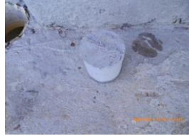
Extracción de núcleos para bajantes sanitarios
