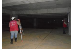
Comisión de topografía para nivelación de placas y control de deflexiones
