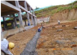
Acondicionamiento de terreno para evacuación de aguas superficialescostado orientalY COSTADO SUR
