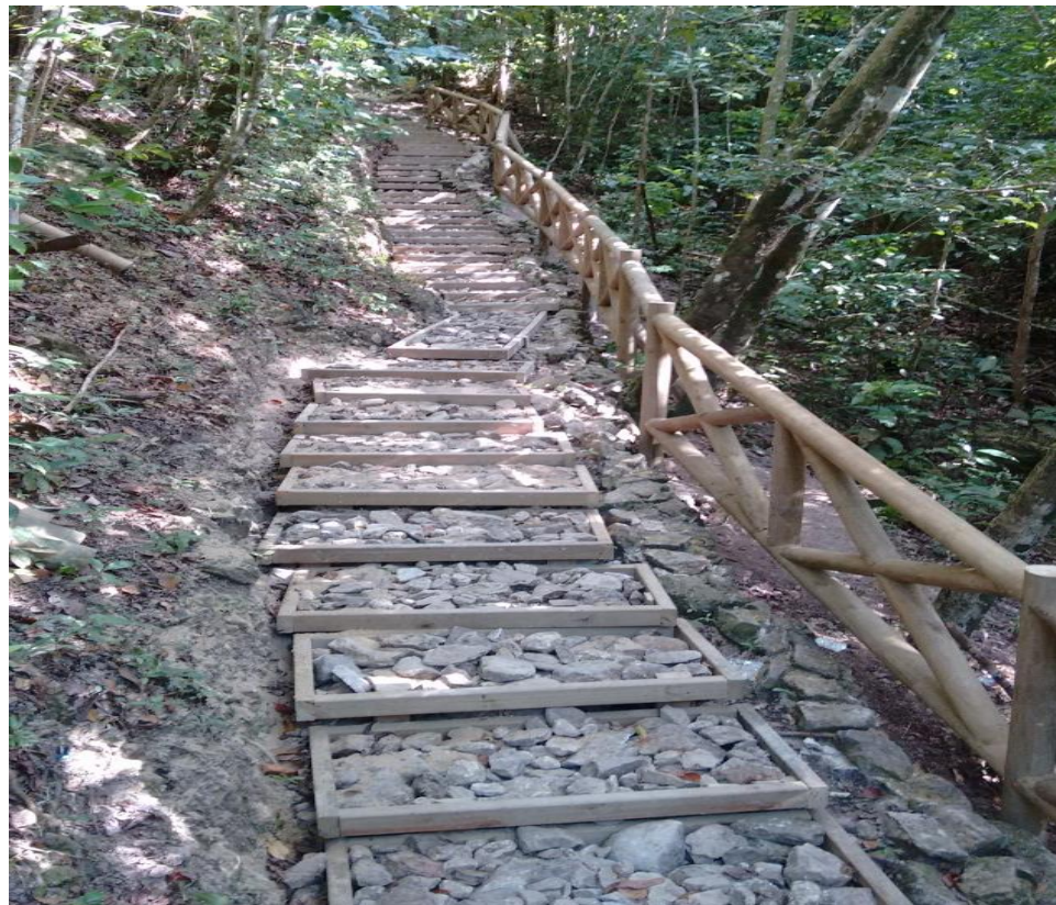
Fig 7 Construcción de escalera con contrahuella en madera y relleno en piedra en k2-150
