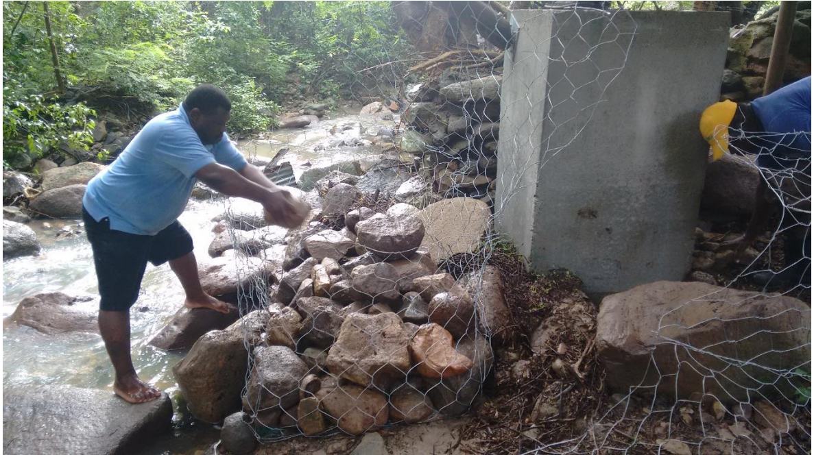
Llenado de mallas para gaviones en k0-120
