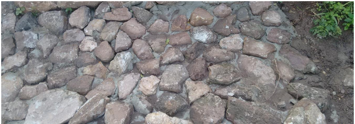
Enrocado de protección en k1-700
