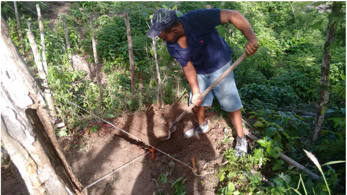
Inicio excavación para pedestales puente en K0-910
