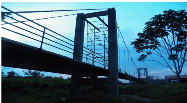
Foto 9: Montaje cables principales y pendones del Puente N° 2
