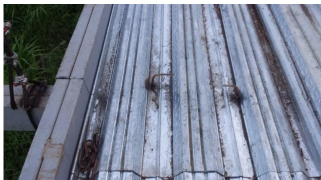
Foto 2: Conectores en varilla soldados a los perfiles metálicos 2C
