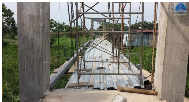
Foto 13: Montaje cables principales y pendones del Puente N° 1
