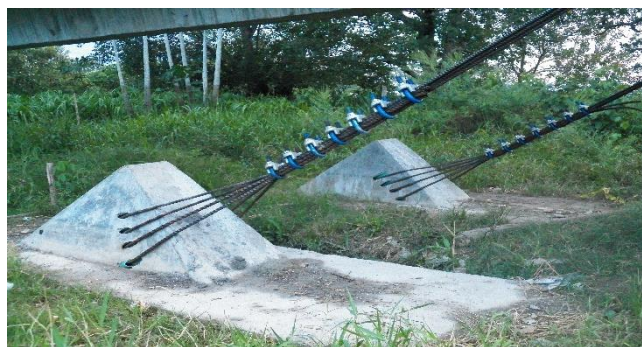
Foto 12: Anclaje del Puente N° 2
