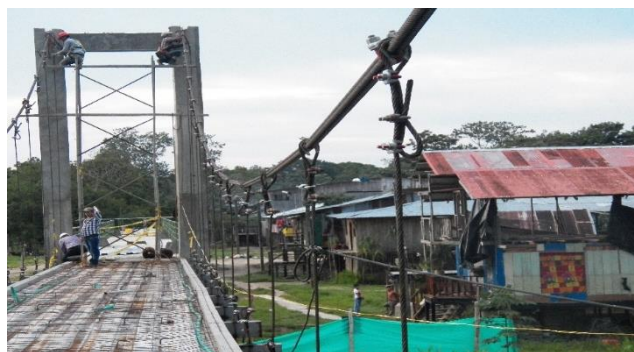
Foto 8: Montaje cables principales y pendones del Puente N° 2
