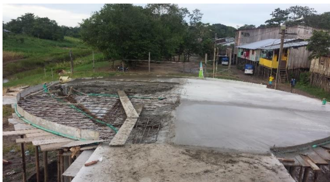
Foto 3: Colocación de concreto mirador N° 3 - K0+500
