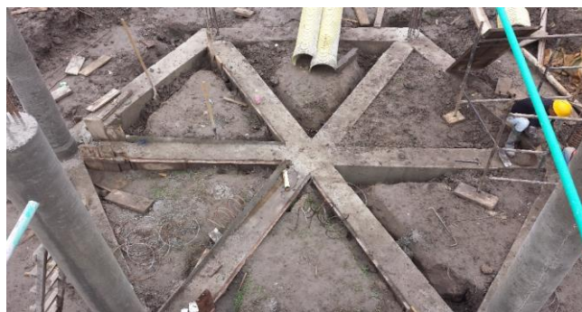
Foto 2: Vigas de cimentación mirador N° 3 - K0+500
