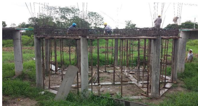
Foto 4: Refuerzo vigas aéreas mirador N° 1 - K0 + 170
