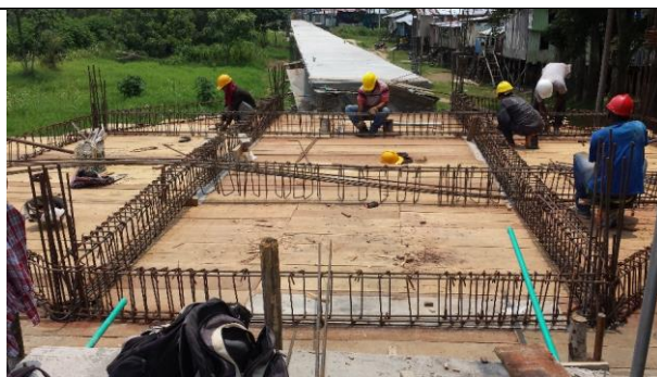
Foto 4: Amarre de hierro vigas aéreas del mirador N° 2 - K0+280
