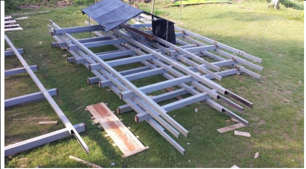
Foto 14: Perfiles metálicos 2C para puentes colgantes
