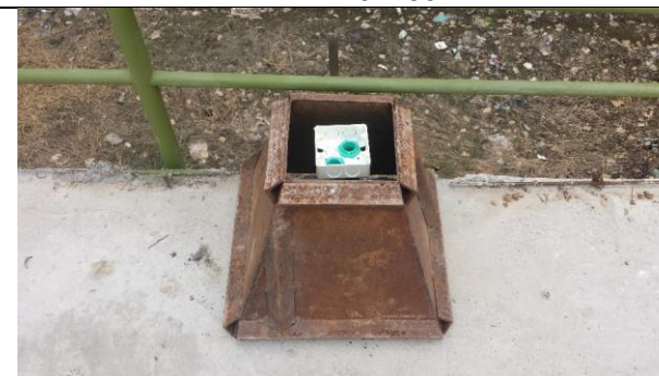
Foto 6: Formaleta para pedestales de postes de iluminación del sendero.
