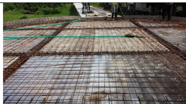
Foto 8: Refuerzo vigas aéreas y placa mirador N° 2 - K0+280
