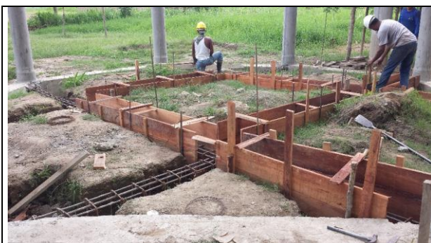
Foto 1: Viga de cimentación del mirador N° 2 - K0+280
