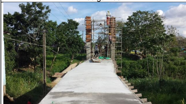
Foto 5: Columnas Puente N°1 (P1B) - K0+125
