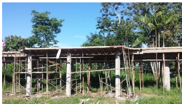
Foto 2: Formaleta para balcón en el tramo 4
