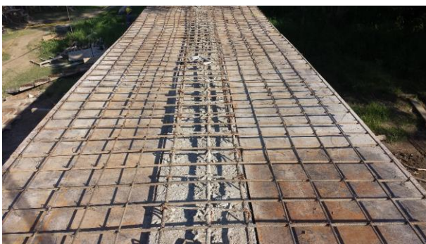
Foto 1: Refuerzo para viga placa tramo 4
