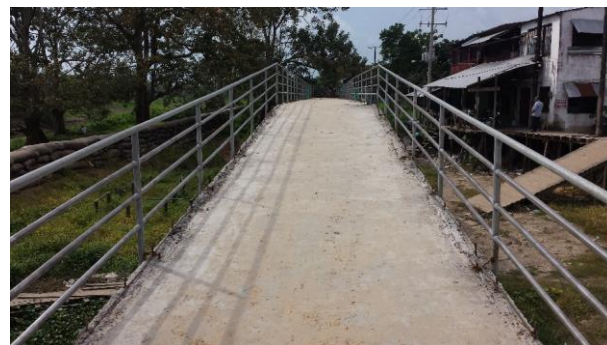
Foto 8: Instalacion de barandas en el tramo 1 acceso al sendero
