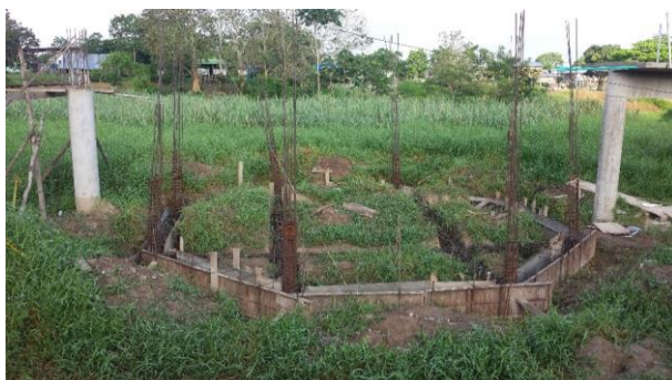
Foto 9: Refuerzo viga de cimentación mirador N° 1 - K0 + 170
