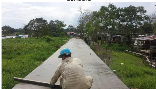
Colocación de concreto placa tramo 3
