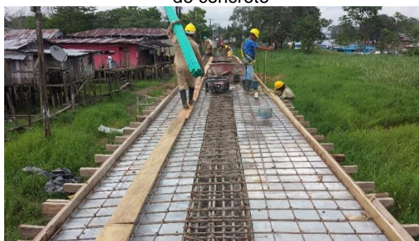
Refuerzo placa sendero tramo 3.
