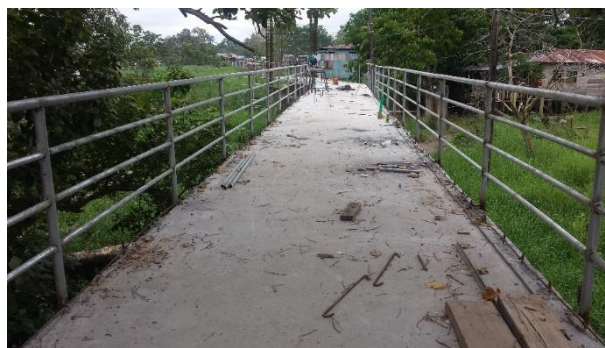
Instalación de barandas tramo 1
