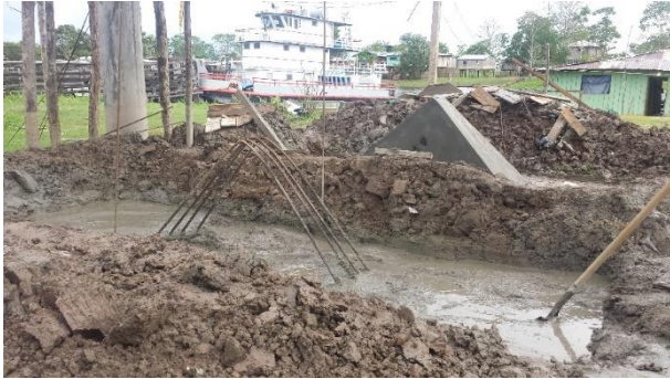
Refuerzo para anclaje P2B ( Puente colgante 2)
