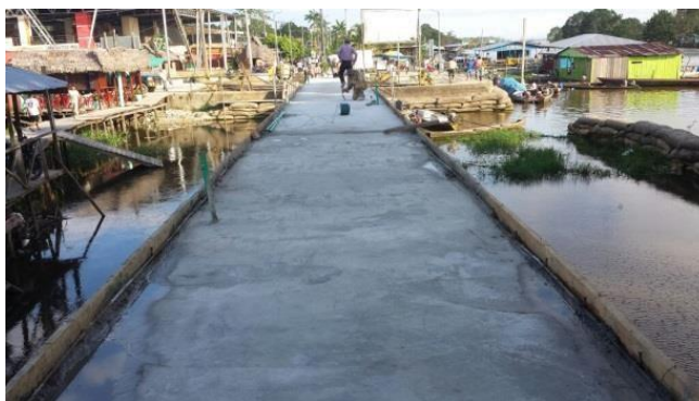
Fotografías 3 y 4. Fundida de la primera sección de placa – amarre de hierro para la placa
