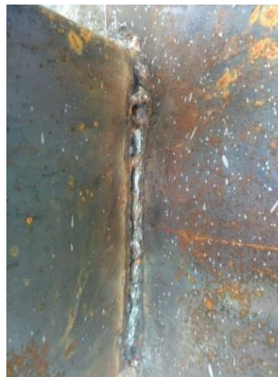
Fotografía 13, 14, 15 y 16. Reparación de soldaduras en cercha metálica acceso a sendero
