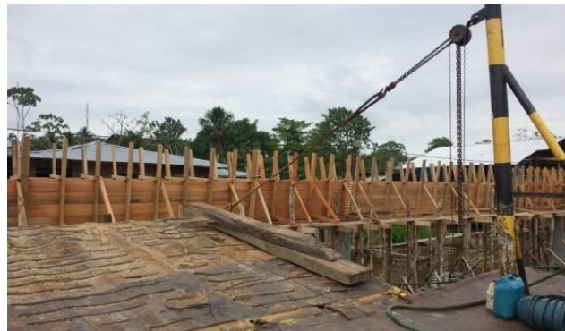
Fotografías 9, 10, 11 y 12. Armada y fundida de viga, tramo sector calle 13
