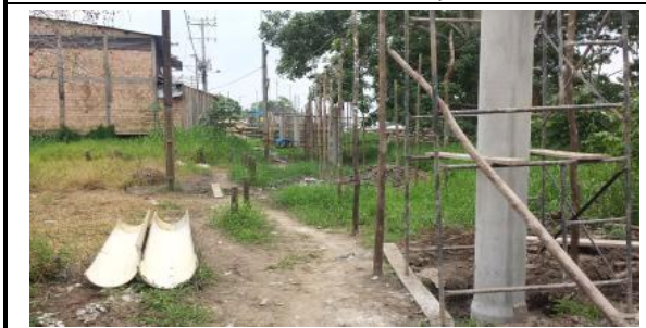
Foto 11: Cimentación y refuerzo columnas Mirador N° 2
