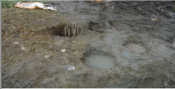
Foto 6: Excavacion para zapatas
