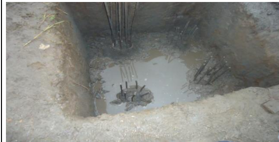
Foto 8: Fundida de zapatas
