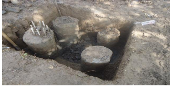
Foto 7: Instalacion de refuerzo para zapatas y columnas
