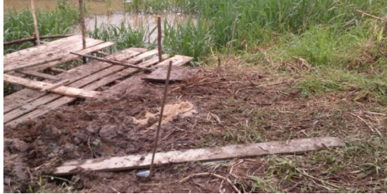
Plataformas para perforar en el puente 1
