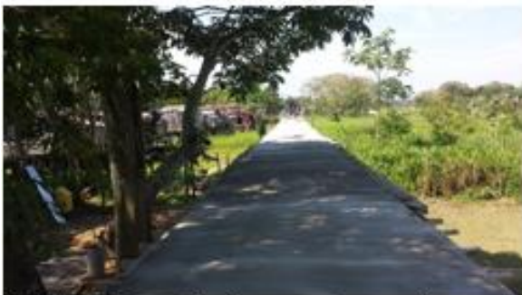
Foto 11: Colocación de concreto para placa en el tramo N°3 - K0+250
