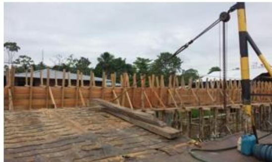
Fotografías 9, 10, 11 y 12. Armada y tundida de viga, tramo sector calle 13
