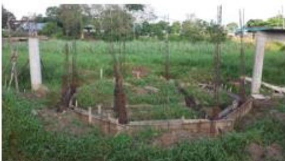
Foto 9: Refuerzo viga de cimentación mirador N° 1 - K0 + 170
