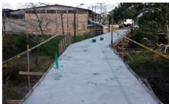
Colocación de concreto para placa en el tramo 1
