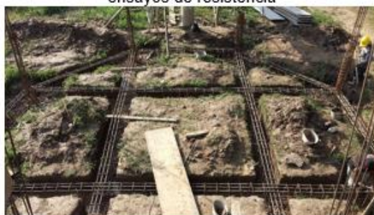
Foto 6: Instalación refuerzo viga de cimentación mirador N°2
