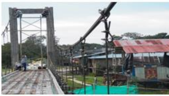
Foto 8: Montaje cables principales y pendones del Puente N° 2
