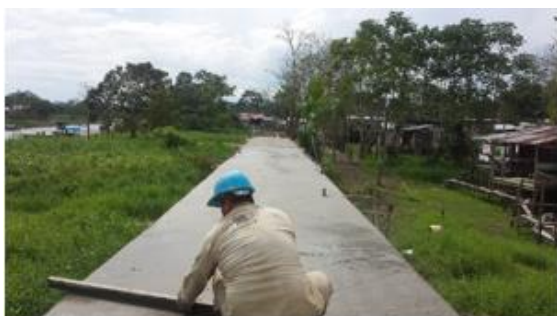
Colocación de concreto placa tramo 3
