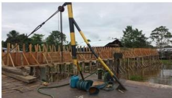
Fotografías 9, 10, 11 y 12. Armada y tundida de viga, tramo sector calle 13
